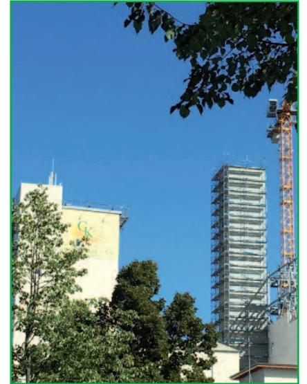
durch eine Stahlkonstruktion. Es wird durch die Firma Steros aus einzelnen Stahlelementen zu Silozellen montiert und zusammengeschrubt.
