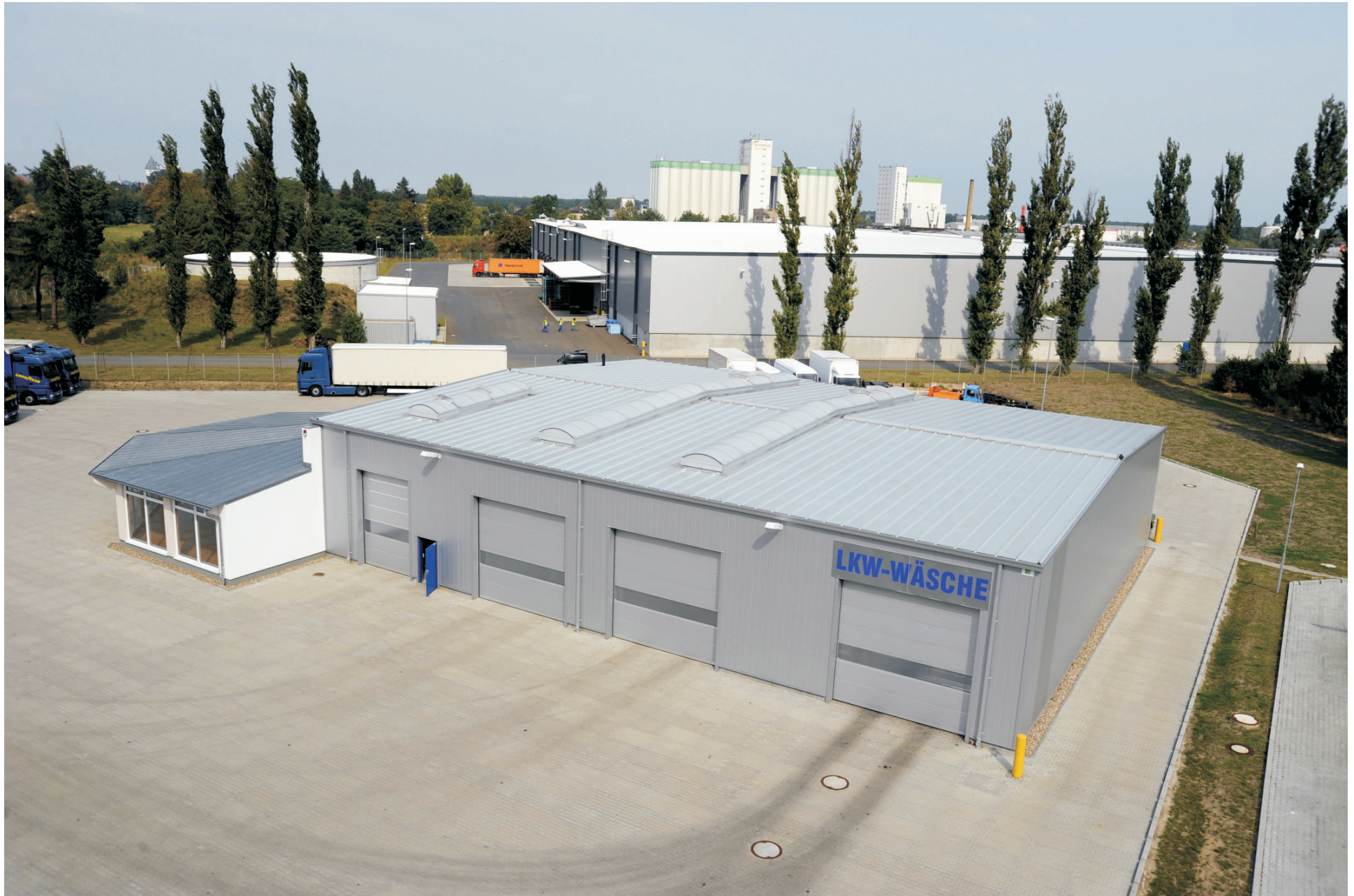
Werkstatt mit Waschanlage LKW, Langewahler Straße, Gewerbegebiet, 15517 Fürstenwalde Typ: AZM 1, 756,00 m 2 , 25,20 m x 30,00 m, Trh. 6,00 m, Dachneigung 1 : 24, Dezember 2007 - Februar 2008
