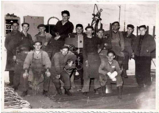
Abb. 9: Bewehrungsbauer/Eisenbieger in den 1950er Jahren.
