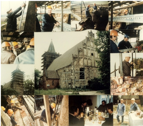
Abb. 24: Sanierung der Kirche in Komptendorf.
