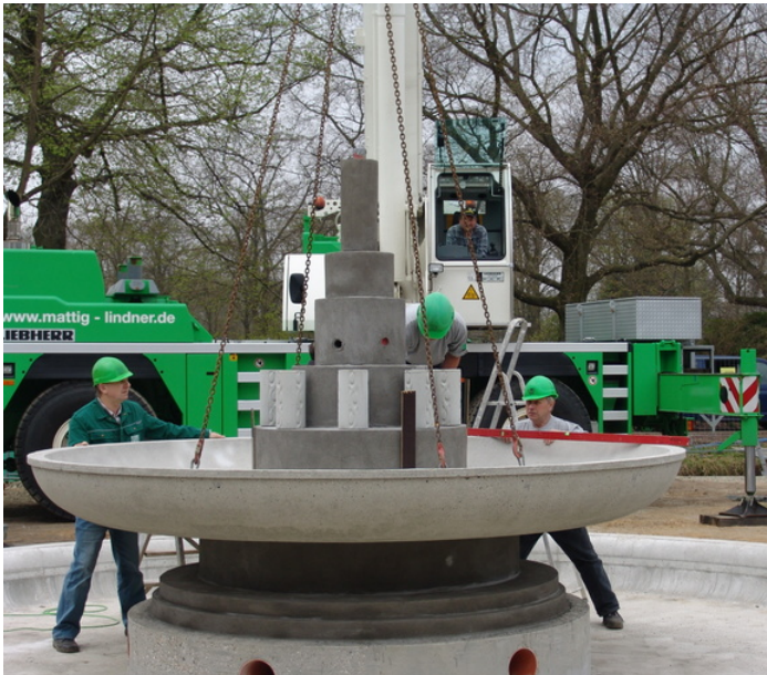
Abb. 31: Montage des nachgebauten Kaskadenbrunnens im Ostdeutschen Rosengarten 2013.
