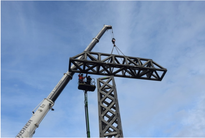
Abb. 25: Der Demonstrationsturm in Stabgitterbauweise mittels Beton-Fertigteilen.
