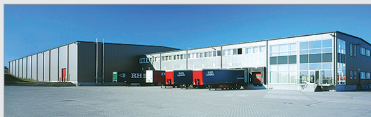
Logistikzentrum Spedition Dahmen 7 200 m 2 Lager Umschlaghalle EG (Stahlbeton) 1 800 m 2 Büro/Verwaltung OG (Stahlbau) 1 800 m 2 Industriepark Höingen, Harkortstraße, Ense (Ref. 106)
