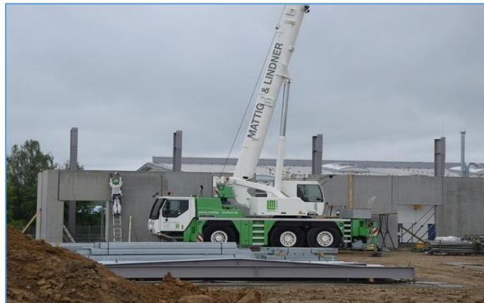
Montage eines Betonfertigteilelements Quelle: MATTIG & LINDNER GmbH
