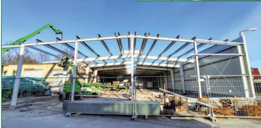
Nun wird nach einer längeren Planungsphase auf dem Firmengelände eine 1240 m<sup>2</sup> große Stahlbauhalle mit einem Büroeinbau und einem kleinen Farblager im Mauerwerksbau errichtet.
