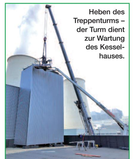
Heben des Treppenturms – der Turm dient zur Wartung des Kesselhauses.
