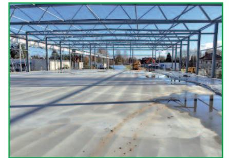
Die 25 cm Bodenplatte erhielt zweilagige Bewehrungsmatten und der Beton konnte wie geplant am 25. November komplett eingebracht werden. 380 m<sup>3</sup> Beton kamen aus Simmersdorf, Peitz und Luckau. Das bedeutet, dass 14 Fahrten unentwegt über zehn Stunden Beton lieferten. Der Beton wurde mittels zwei Betonpum-
