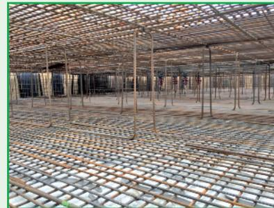
Für die 1,70 m starke und 760 m<sup>2</sup> große Fundamentplatte des Turms, des Maschinenhauses und der Gossenanlage wurden im November 144 Tonnen Stahl verlegt und ca. 1300 m<sup>3</sup> Beton in mehreren Lagen an einem Tag in der Zeit von 17 Uhr bis 5 Uhr früh eingebaut. Das Foto zeigt den 18 mm bis 28 mm Bewehrungsstahl in jeweils 5 bis 6 Lagen. Die oberen Lagen werden durch Stützböcke getragen.
