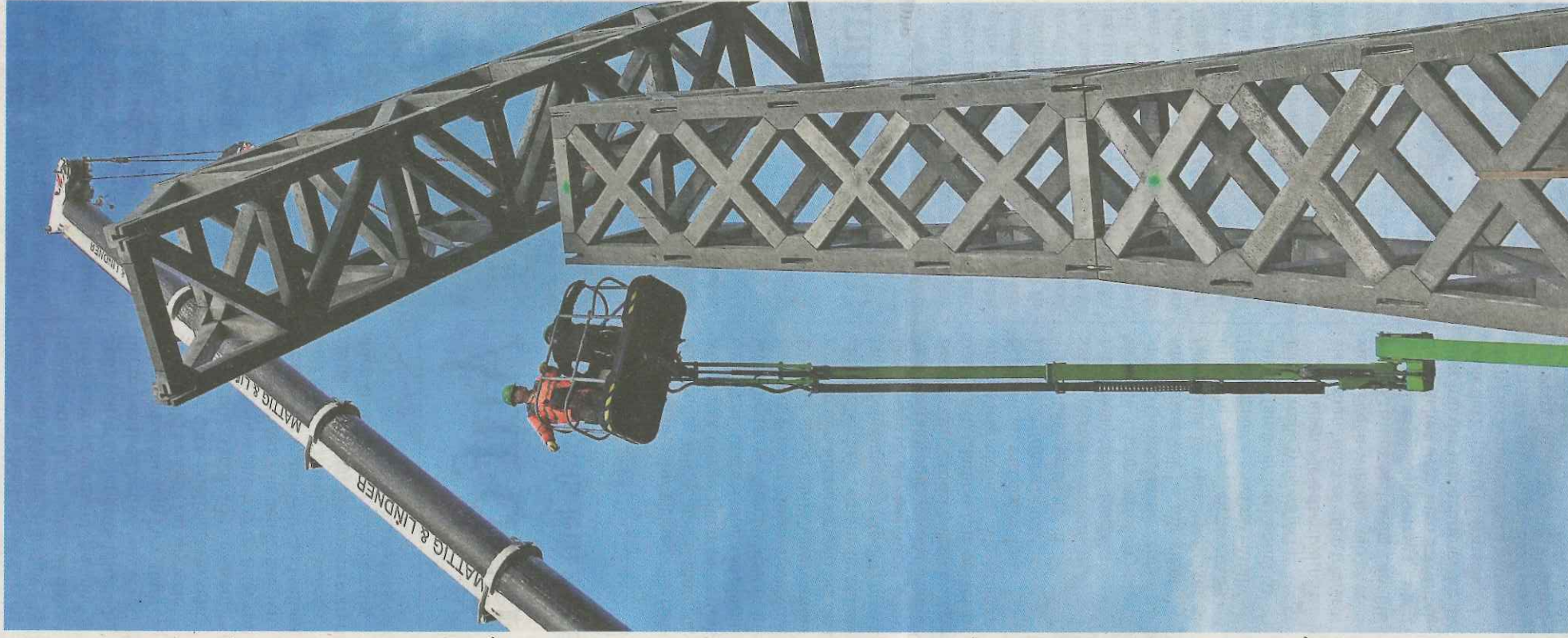
Auf dem Betriebsgelände in Forst hat das Unternehmen Mattig & Lindner einen Versuchsturm errichtet. Mit Sensoren wird jetzt die Belastung des Materials ermittelt.
