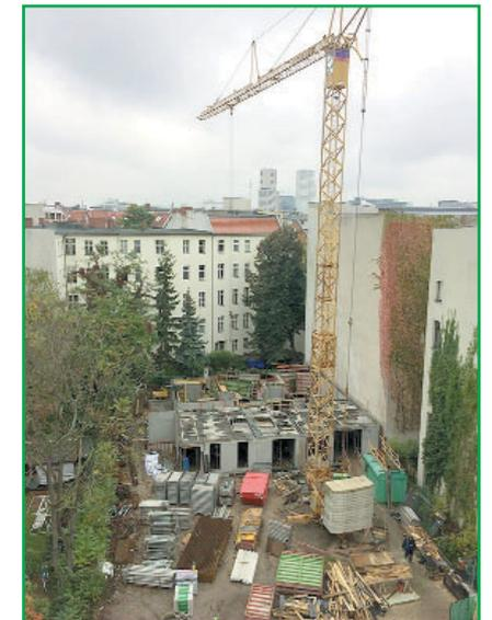
Die Decken werden mit einem Deckenschalungssystem monolithisch eingeschalt. Dieses Schalungssystem wurde ebenfalls für diese Berliner Baustelle neu erworben. Die Deckenfläche beträgt insgesamt ca. 2 800 m<sup>2</sup> und somit pro Etage 400 m<sup>2</sup>.
