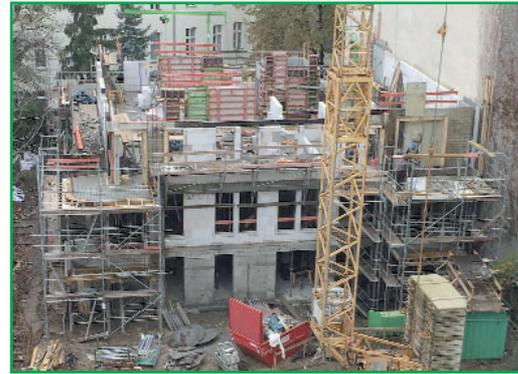
mittels Radlader in den Hof befördert. Kleine Mengen Beton werden mit Radlader und Betonkübeln ebenso transportiert und große Mengen über ein Rohrsystem von draußen gepumpt und mit einer am Kran hängenden Traverse verteilt. Zurzeit ist dieses Rohrsystem bis zum 3. OG Decke ca. 100 m lang! Ein erheblicher Mehraufwand ist somit auch das Installieren und Rückbauen der Leitung
