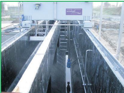
Alle Bauwerke werden in monolithischer Stahlbetonweise hergestellt und haben eine Gesamtlänge von ca. 55 m. Die technische Ausrüstung, die im September begann, sowie die Verkleidung der Bauwerke ist nicht Bestandteil unserer Leistungen. Bauleiter ist Jürgen Kossatz und Polier vor Ort Henry Winzer. In Hochzeiten arbeiteten zehn Mitarbeiter auf der größten öffentlichen Baustelle des Jahres in
