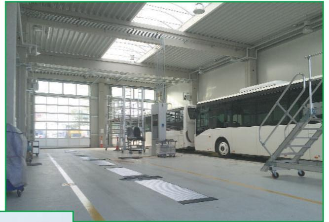
**Werkstatt**, Am Verkehrshof 6 in Potsdam, errichteten wir eine Stahlbetonhalle 29,00 m x 13,90 m mit einem Lichthof/Übergang 24,60 x 2,50 m einschließlich einer Montagegrube aus Stahlbeton und Kassettengrube im Sommer des Jahres (Foto oben).
