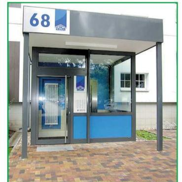
Weiterhin ist der Umbau von 17 Aufzugsvorhäusern Wohnanlage »Mühlengrund & Storchennest« in Berlin/Hohenschönhausen mit Abriss und Neubau abgeschlossen. Zur kompletten Leistung gehörte ein möglichst lärmfreier Abriss, der Neuaufbau durch eine Stahlkonstruktion, Ausbau, Trockenbau und Malerarbeiten.
